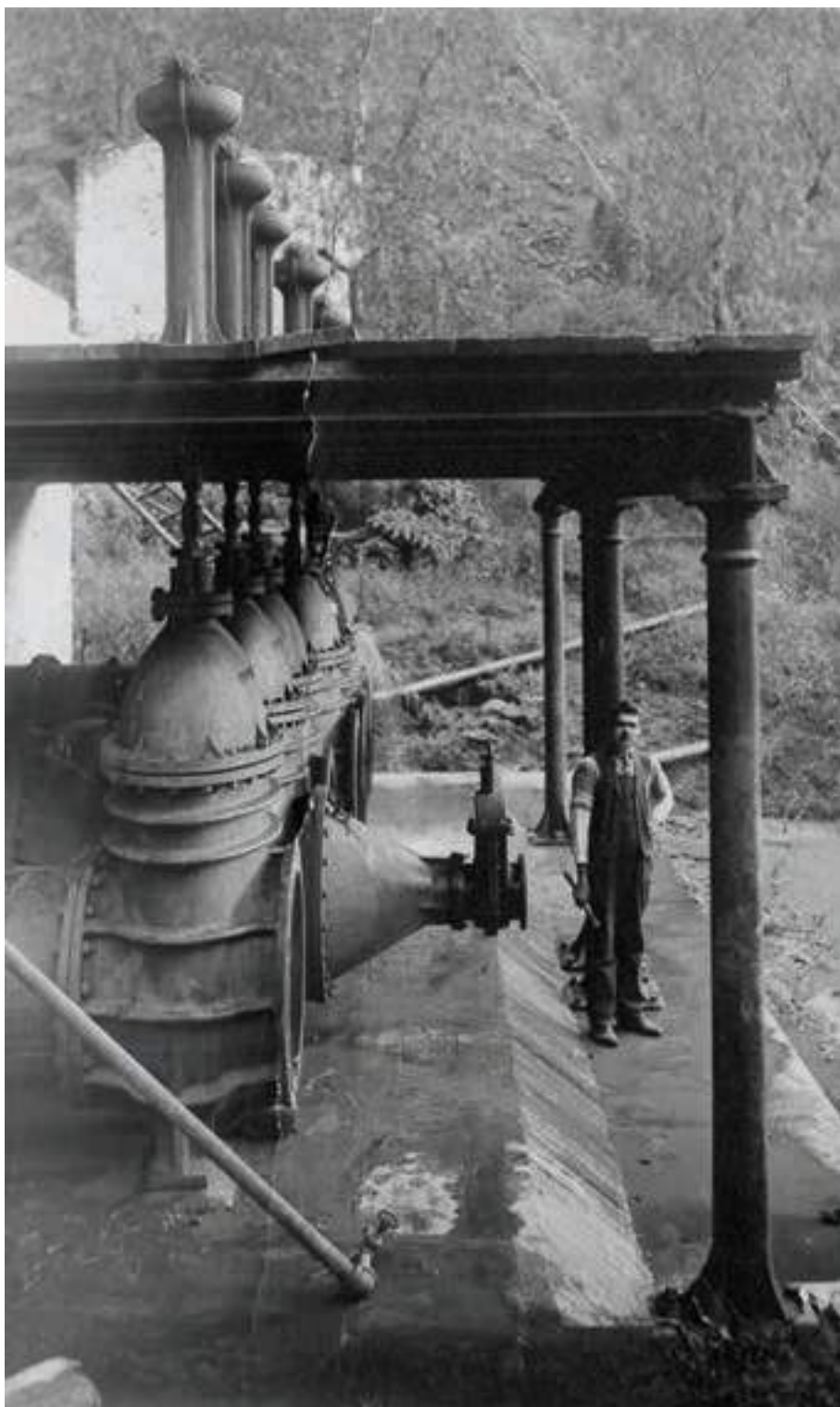
Vista lateral de la bomba hidráulica de la Presa de la Esperanza, símbolo del avance tecnológico propio de la época del Porfiriato.
