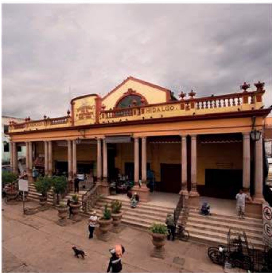
La fachada principal del Mercado Hidalgo , con su pórtico de columnas pareadas, de elegantes reminiscencias neoclásicas.
