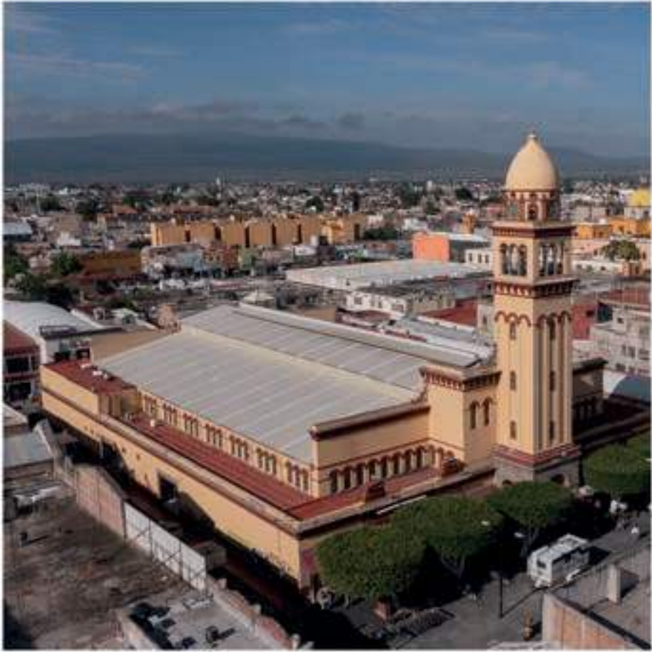
Su icónica torre-reloj destaca sobre el conjunto del Mercado Morelos.
