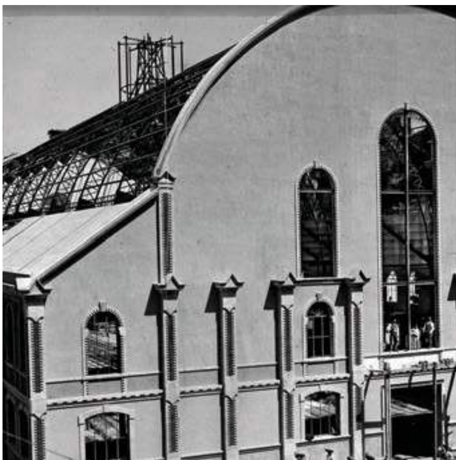
Fachada lateral del Mercado Hidalgo de Guanajuato, donde se aprecia el proceso de construcción de su cubierta. INAH. Número de identificación: 9255
